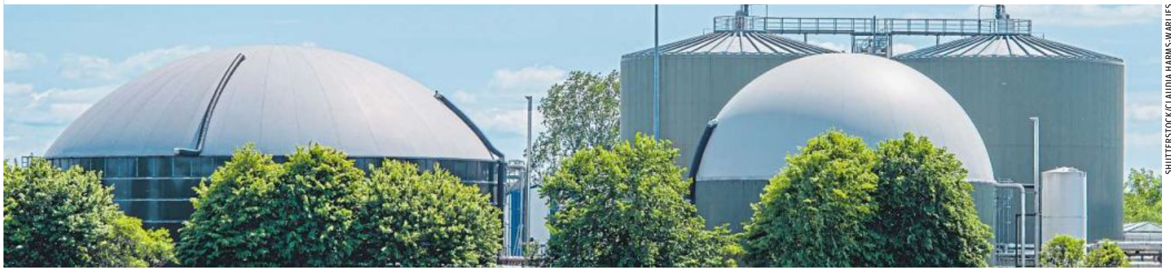
In der Biogasanlage wird Biomasse zu CO 2 -neutralem Biogas vergoren. Wird es zu Biomethan veredelt, kann es direkt ins Gasnetz eingespeist werden
